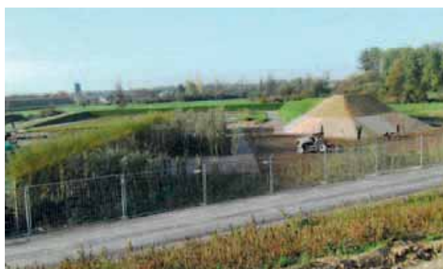
Aktuelle Ansicht – die Weiden haben gut angetrieben und das Gras ist gesät – es fehlen nur noch der Forst-Pavillon und die verschiedenen Ausstellungselemente
