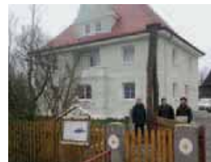
Das neue Bürogebäude der WBV Landau in Gosselding – eingeweiht im Mai 2014
