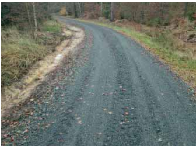
Eine gepflegte und intakte Forststraße
