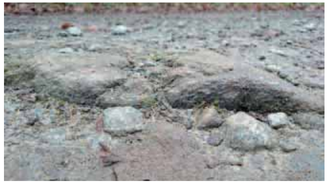
Wenn das Deckmaterial ausgewaschen wird entstehen Schlaglöcher – der Wegekörper wird zum Hindernis (hier: Steine ragen aus der Fahrbahn)
