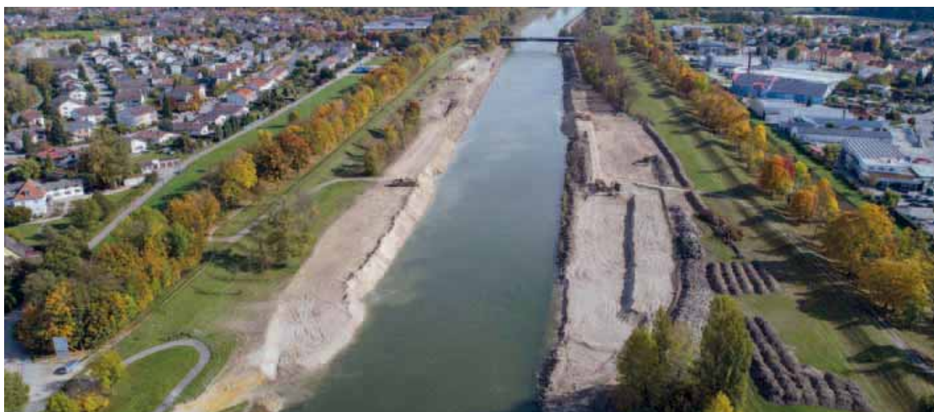
Die Renaturierung der Isar zwischen Dingolfing und Gottfrieding schreitet zügig voran. Beiderseits werden Schritt für Schritt die Uferbefestigungen entfernt und flache Kiesufer geschaffen. Die ausgebauten Wasserbausteine werden zum Schutz der Deiche als sogenannte „schlafende Sicherung“ wieder eingebaut. (Foto: W. Lorenz/Regierung von Niederbayern)
